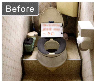
和式便器の上に補高便座をのせて使用していたので、足が浮き、力が入らない。
