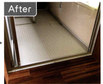
シャワーキャリー(浴室専用車椅子)で入れるようになった。
