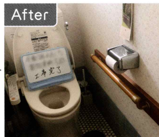
洋風便器に変えて、便座の高さを低くし、後ろを向かなくても洗浄できるようになった。
