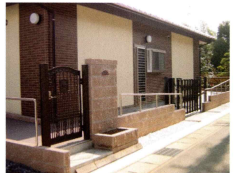
2方向避難のためのスロープの設置。
